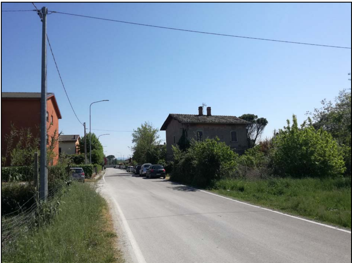
FOTO 16 Vista del casello ex ferrovia Santarcangelo – Urbino dalla via Vecchia Marecchia
